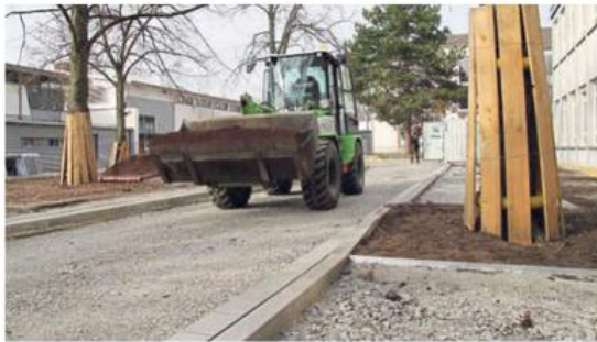
Erdarbeiten stehe derzeit bei der Umgestaltung des Schulhofs an. In einer Woche wird die Zufahrt asphaltiert.
